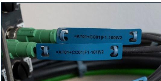
*OPTION: FDA-konforme Kabelbeschriftung mit blauen detektierbaren Kunststoff-Schildern WMTB HF-D (40x12) R BU*
