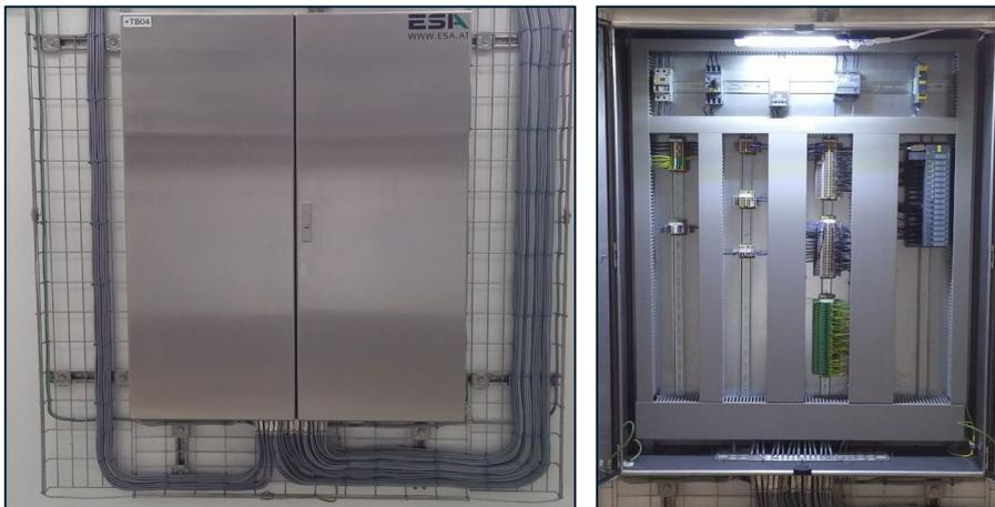
*Steuerungsverteiler mit ET200SP Baugruppen:*
