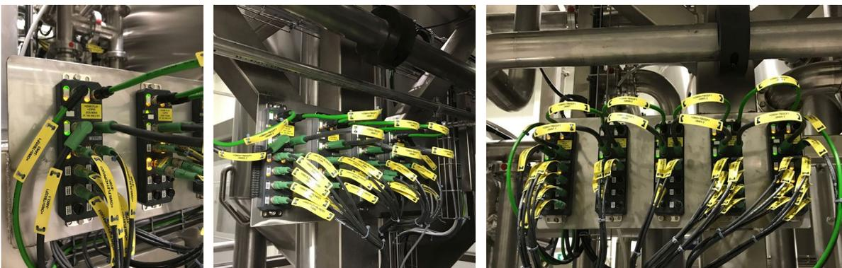
*Dezentrales I/O-Gerät IP67 (Phoenix Axioline E):*
