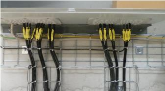
Als Kabelbeschriftung kommen bedruckbare gelbe Kunststoffschilder (55x15mm) zum Einsatz, die mit Kabelbinder an den dafür vorgesehenen seitlichen Löchern am Kabel befestigt werden können. (siehe Bilder oben) Fabrikat: Phoenix Contact.
